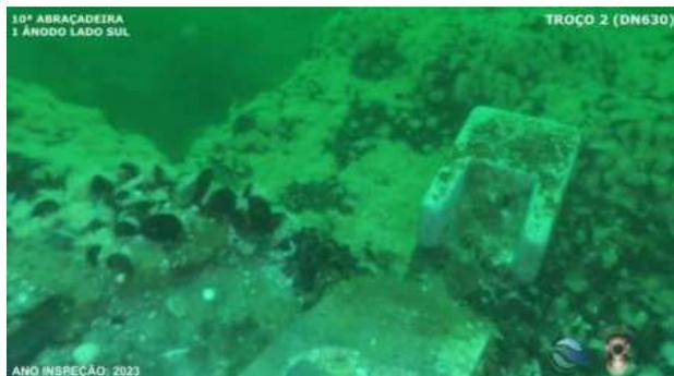
00.04.15 - Bloco 10 - Abraçadeira e fixações sem corrosão, 1x ânodo de PC lado Sul
