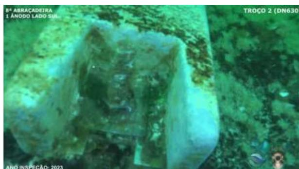
00.02.36 – Bloco 8 – Abraçadeira e fixações sem corrosão, 1x ânodo de PC, vista de Sul
