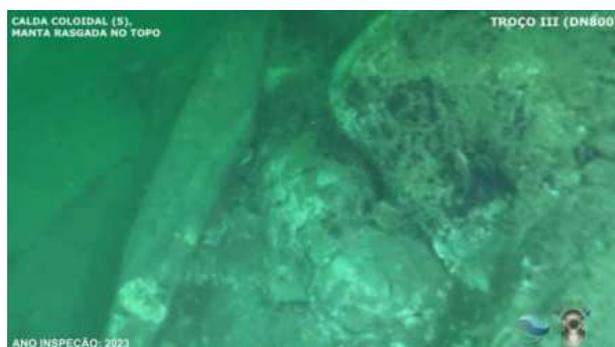
00.01.41 – 5º Maciço calda coloidal visível, rasgado no topo em todas a extensão
