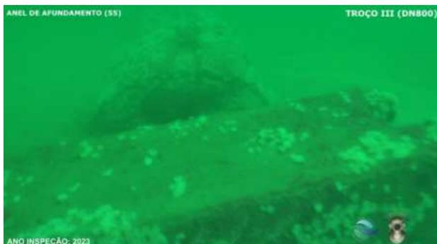
00.20.25 – 55º Anel de afundamento, entre Maciços de calda coloidal
