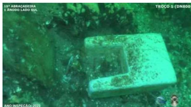
00.07.22 - Bloco 19 - Elementos metálicos sem corrosão, 1x âncora de PC lado Sul
