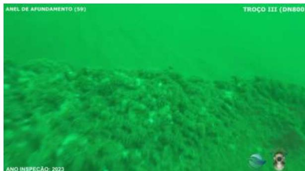
00.21.43 – 59º Anel de afundamento, sem Maciço de calda coloidal
