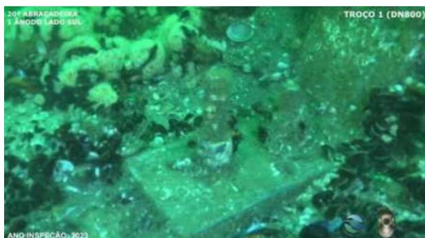
00.08.04 - Bloco 20 - Elementos metálicos sem corrosão, 1x ânodo de PC, fixação vista lado Norte
