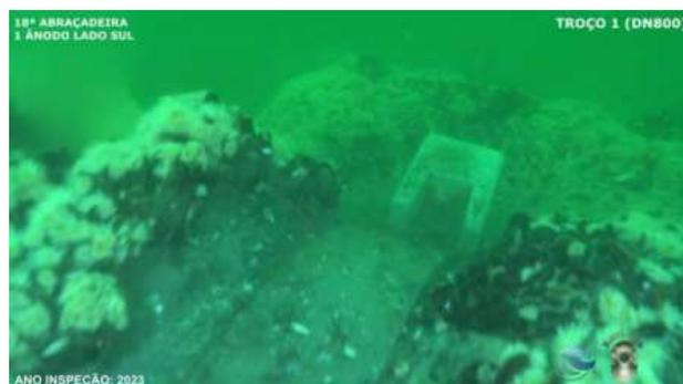
00.06.22 – Bloco 18 - Elementos metálicos sem corrosão, 1x âncora de PC lado Sul
