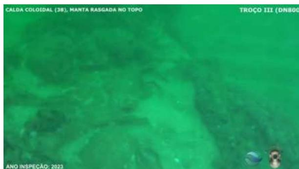
00.14.03 – 27º Maciço de calda coloidal, manta rasgada no topo
