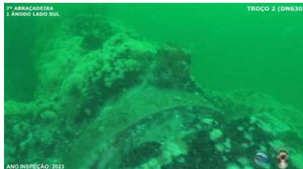
00.01.23 - Bloco 7 - Abraçadeira e fixações sem corrosão, 1x Ânodo lado Sul
