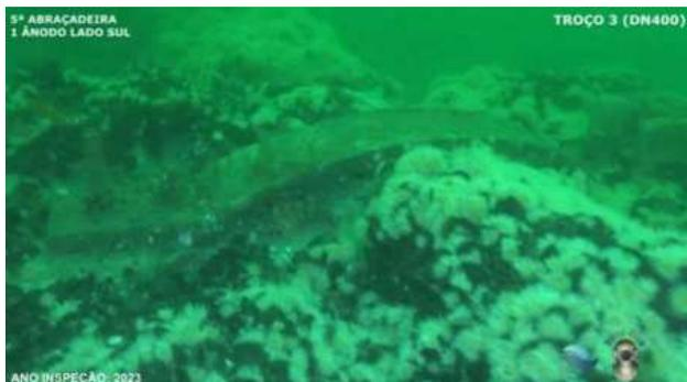
00.04.58 - Bloco 5 - Abraçadeiras e Pernos sem corrosão, 1x âncora lado Sul
