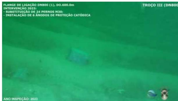
00.05.11 – Flange de Ligação DO.600.0m, foi alvo de intervenção em 08/2023, antes da IS, substituídos 24 pernos e instalados 6 ânodos PC
