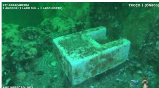
00.07.25 - Bloco 17 - Elementos metálicos sem corrosão, 2s ânodos de PC, ânodo lado Norte
