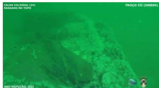
00.11.41 – 24º Maciço calda coloidal, rasgado no topo com calda visível
