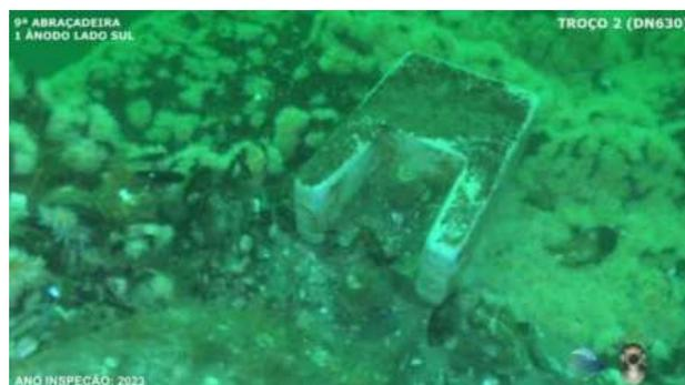
00.03.28 – Bloco 9 – Abraçadeira e fixações sem corrosão, 1x ânodo de PC lado Sul
