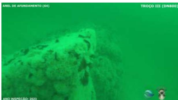
00.23.00 – 64º Anel de afundamento entre Maciços de calda coloidal, rodado para Norte
