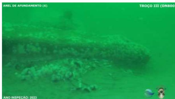
00.04.28 – 6º Anel de afundamento seguido por Maciço de calda coloidal
