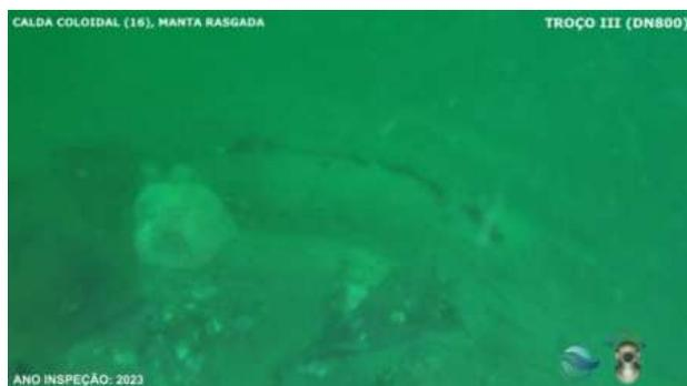
00.05.25 – 16º Maciço de calda coloidal, manta rasgada no topo
