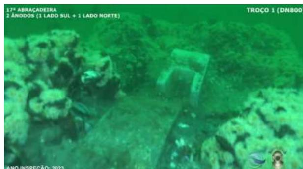
00.05.31 - Bloco 17 - Elementos metálicos sem corrosão, 2x ânodos de PC, ânodo lado Sul
