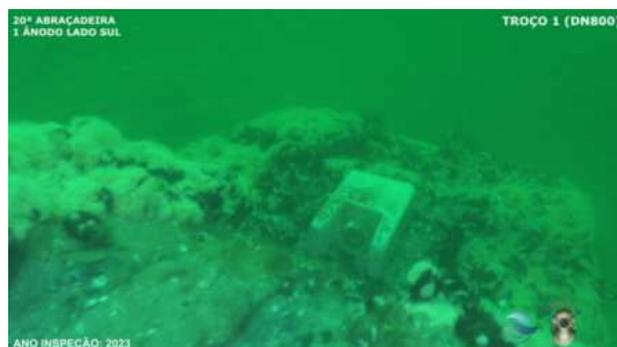
00.08.12 - Bloco 20 - Elementos metálicos sem corrosão, 1x ânodo de PC lado Sul
