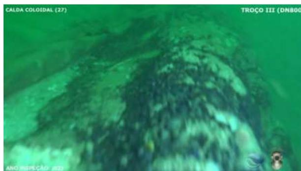
00.11.17 – 27º Maciço de calda coloidal, manta rasgada no topo
