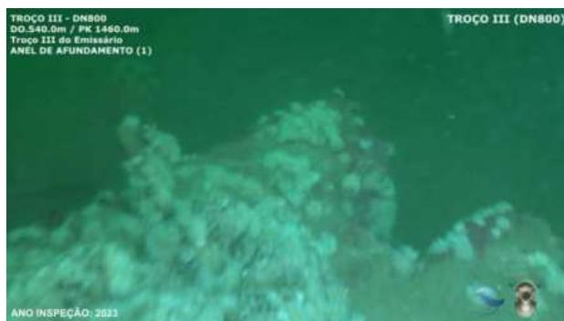
00.00.25 – 1º Anel de Afundamento visível entre maciços de calda coloidal, rodado para Norte
