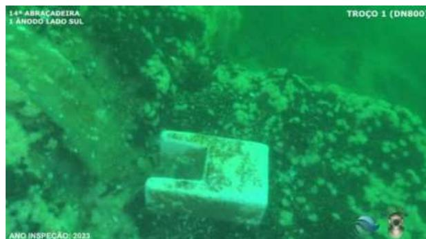
00.02.51 - Bloco 14 - Elementos metálicos sem corrosão, 1x ânodo PC ativa, ânodo lado Sul
