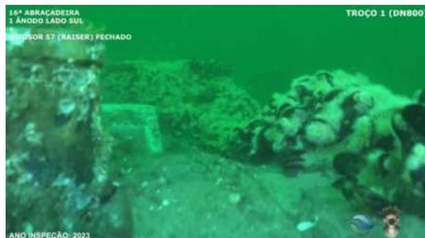
00.04.21 – Bloco 16 - Elementos metálicos sem corrosão, 1x ânodo de lado Sul + D.57 - tamponado
