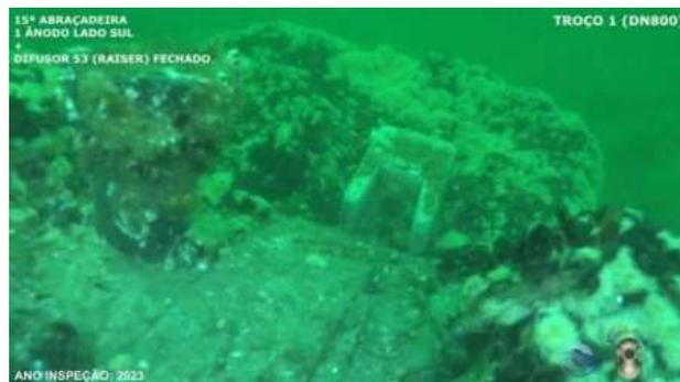
00.03.20 - Bloco 15 - Elementos metálicos sem corrosão, 1x ânodo de lado Sul + D.53 - tamponado
