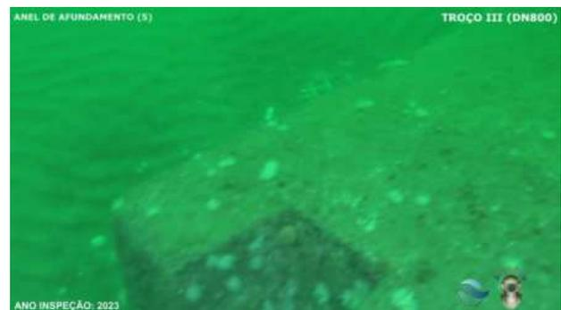
00.03.58 – 5º Anel de afundamento, ausência de Maciço calda coloidal entre 5º e 6º anel
