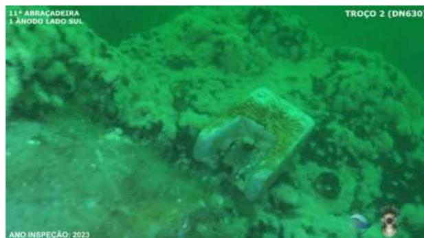
00.05.13 - Bloco 11 - Abraçadeira e fixações sem corrosão, 1x ânodo de PC lado Sul
