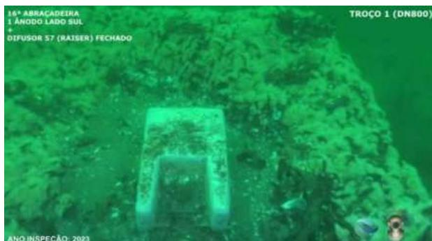
00.04.25 - Bloco 16 - Elementos metálicos sem corrosão, 1x ânodo de PC, lado Sul
