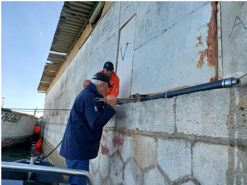
Fig. 4 – Amostrador vertical de sedimentos (tipo MORAN) a ser preparado..
