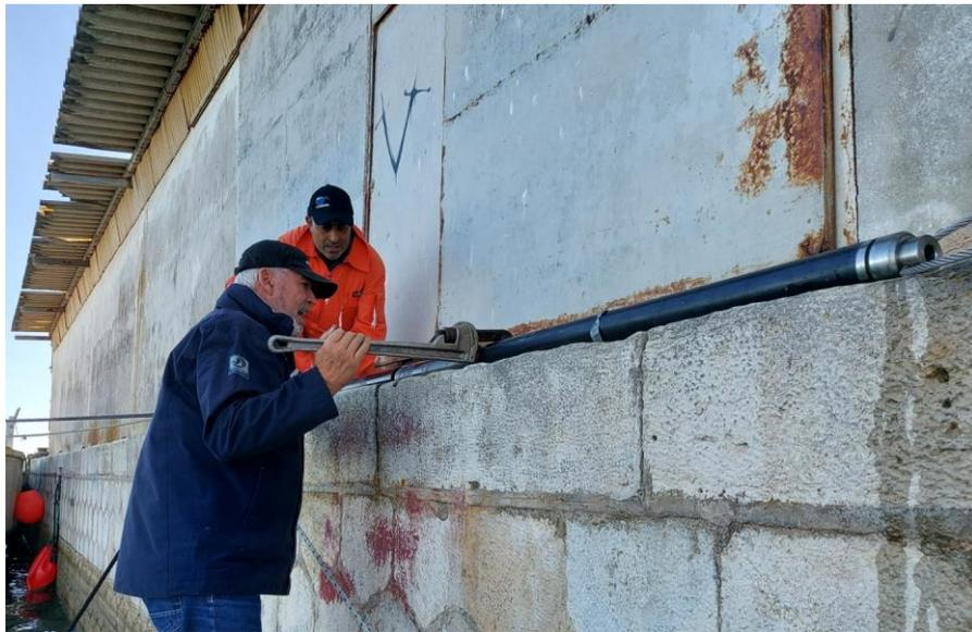
Fig.10 – Amostrador a ser desmontado após a colheita em VRST 2, para extracção dos Liners.
